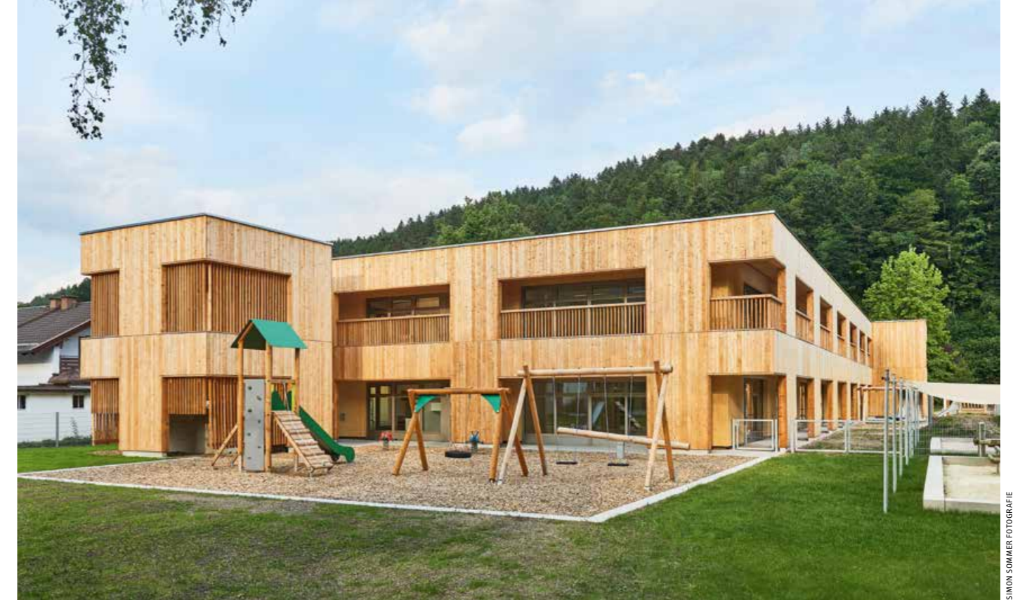
▲ Am Umgang befinden sich zwei Treppentürme, die als Fluchttreppe und als Spielturm für die Kinder geplant wurden
