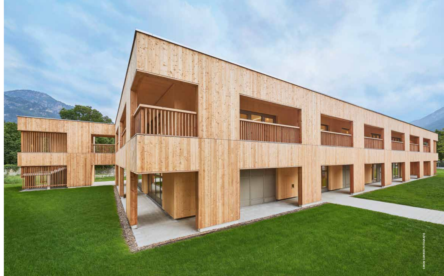
▲ Der in Holzständerkonstruktion geplante Umgang der neuen Kita in Bad Reichenhall dient als Spielfläche, Fluchtbalkon und als feststehendes Verschattungselement
