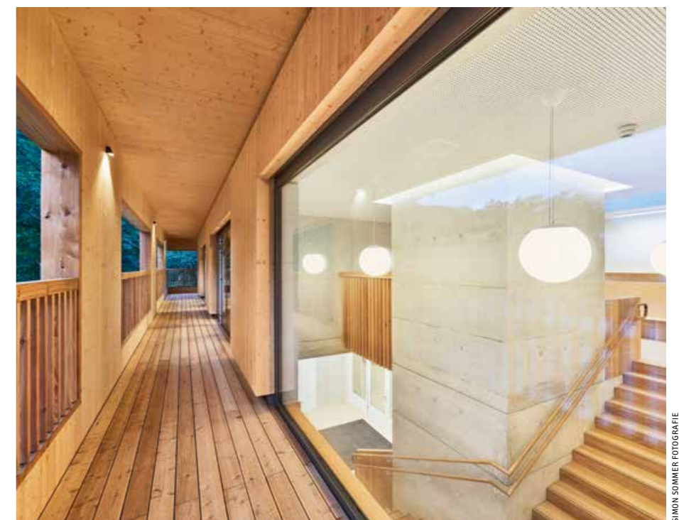
▲ Während außen Holz dominiert, wurde das innere Treppenhaus in Sichtbeton errichtet
